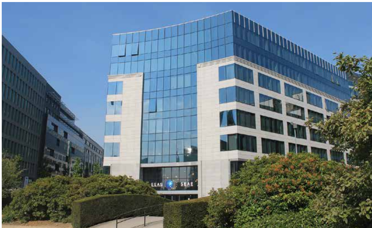
Zgrada Evropske službe za spoljne poslove u Briselu
